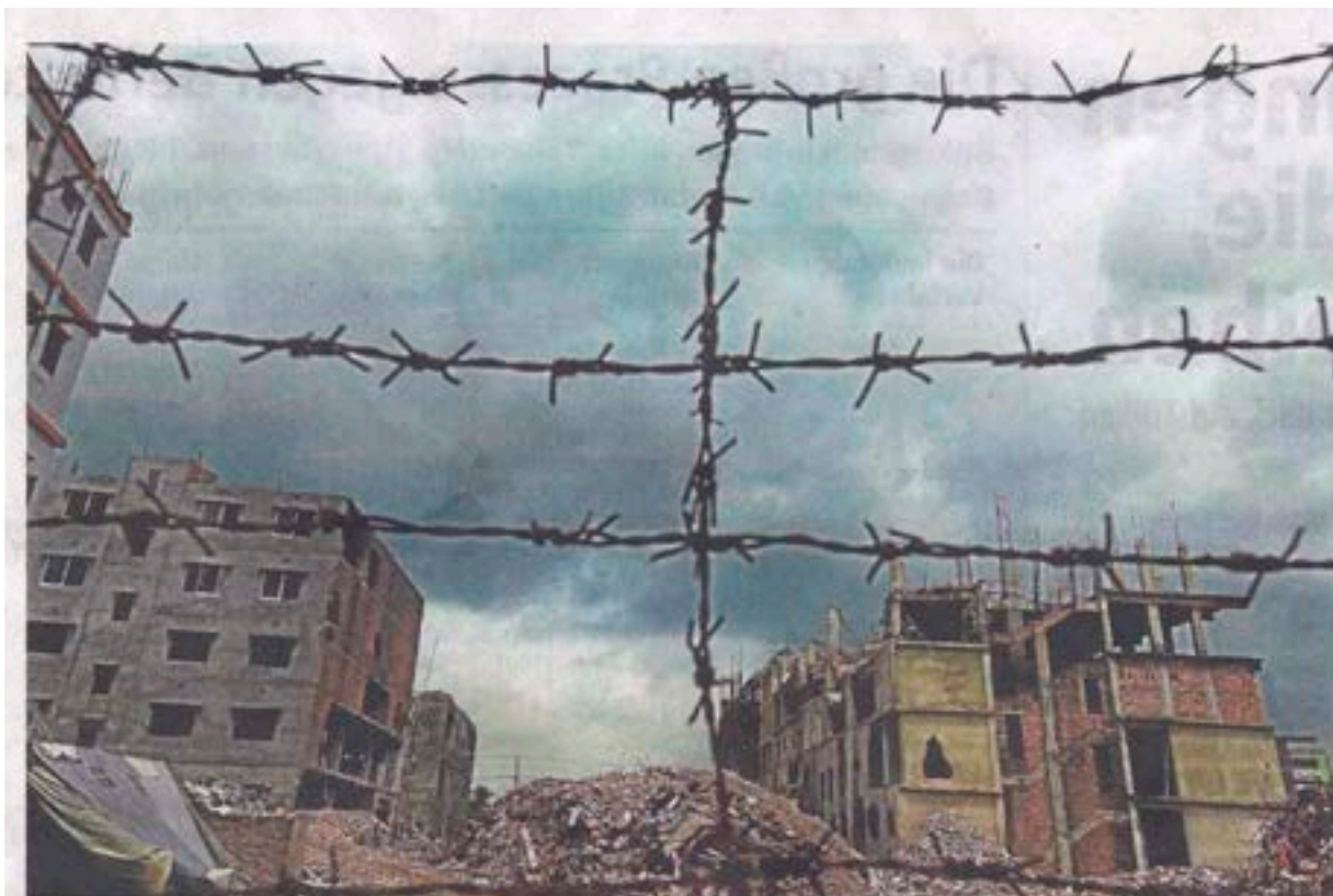
1127 Menschen starben beim schlimmsten Fabrikeinsturz in der Geschichte Bangladeschs; rund 2500 Menschen wurden im April beim Einsturz des achtstöckigen Gebäudes in einem Vorort von Dhaka verletzt.
